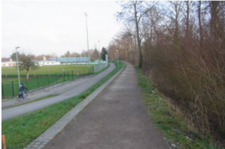
Abb. 25. Hochwasserschutz, Damm entlang der Pfrimm in Worms-Pfiffligheim, Januar 2016, © Klima-Bündnis.
