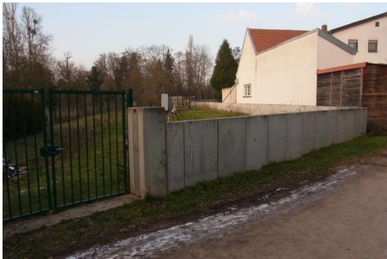
Abb. 26. Hochwasserschutz, Schutzmauer entlang der Überschwemmungsflächen der Pfrimm in Worms-Pfiffligheim. Am Tor können bei Bedarf Dammbalken eingesetzt werden, Januar 2016, © Klima-Bündnis.
