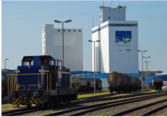
Abb. 46. Industrie in der Hafenstraße. Im Hintergrund das Gebäude der Rhenania Worms AG, © Stadt Worms.
