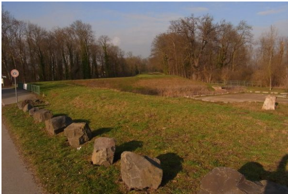
Abb. 23. Hochwasserschutz, Rheindeich in der Nähe des Rheins in Worms, Höhe Friedrichsweg, Januar 2016, © Klima-Bündnis.
