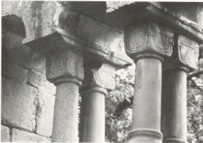
5. Eberbach, Mittelburg Östliche Arkade der Palas-Südwand
