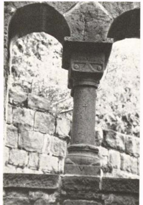
6. Eberbach, Mittelburg Westliche Arkade der Palas-Südwand
