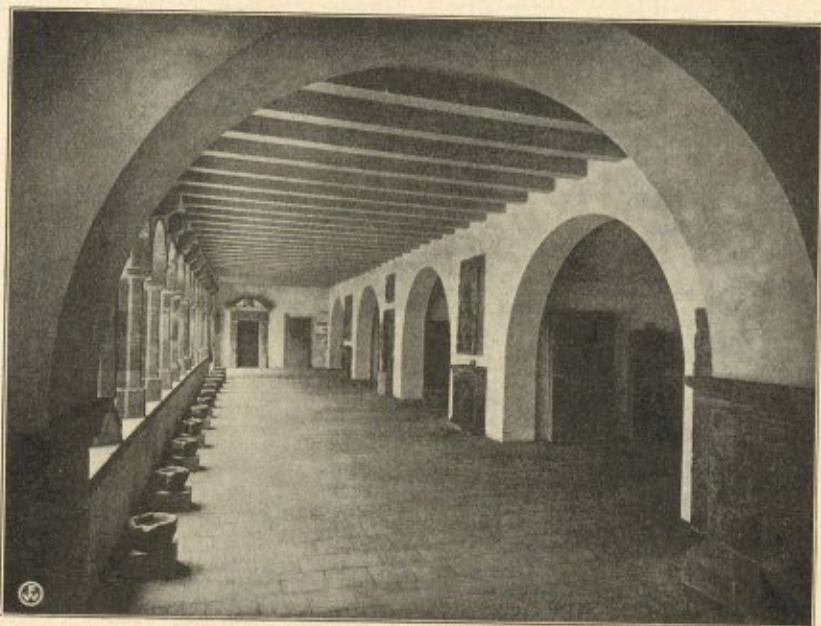
Abb. 29: Südlicher Kreuzgangflügel, Innenansicht mit den Nischen der Stadtmauerbögen
