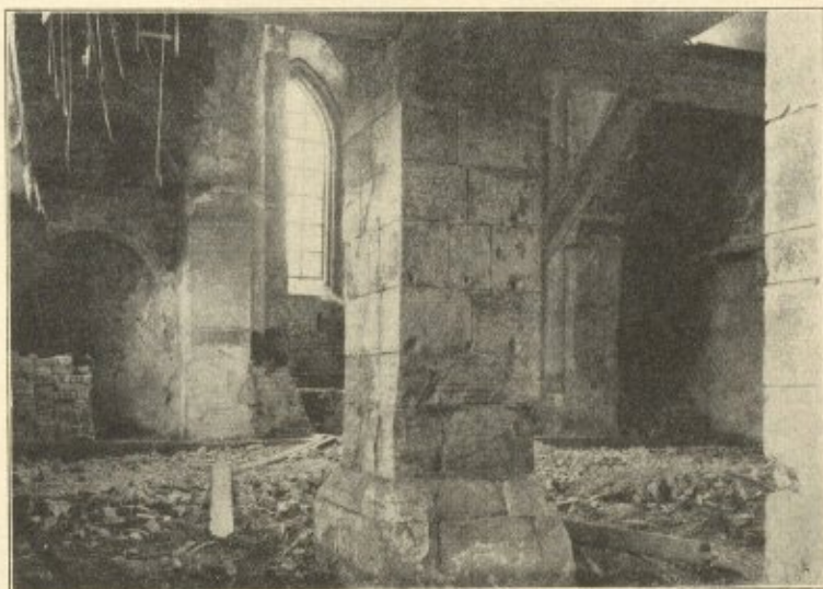
Abb. 19: Inneres der Kirche vor der Wiederherstellung, links Aptide des nördlichen Seitenschiffes, rechts daneben gotisches Chorfenster
