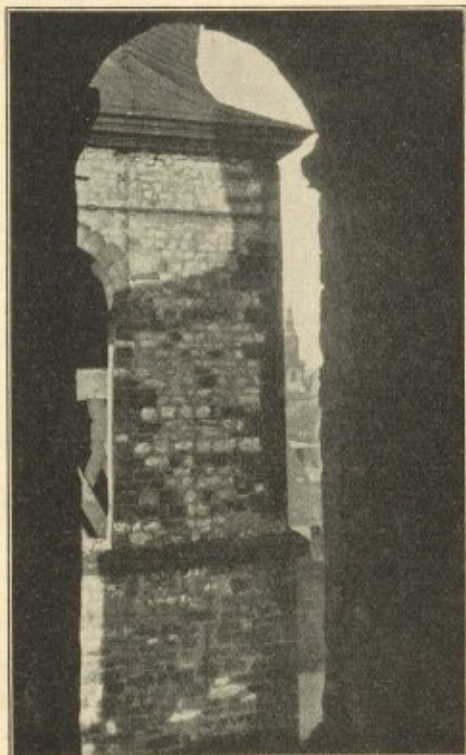
Abb. 11: Außenansicht des Südturmes, das rote Bruchsteinmauerwerk wird belebt durch weiße Kalksteine
