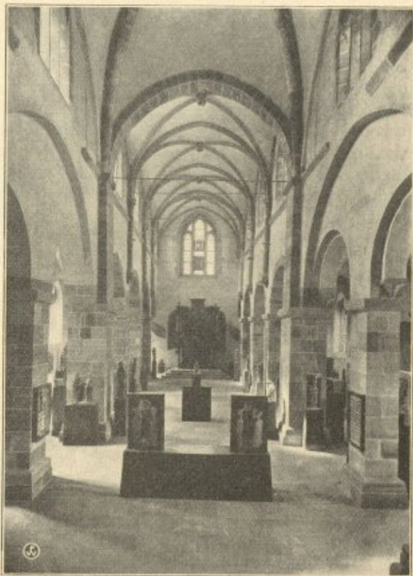
Abb. 3: Innenansicht mit Pfeiler und Triumphbogen des Kreuzaltarraumes im Vordergrund, Blick nach dem Westgiebel
