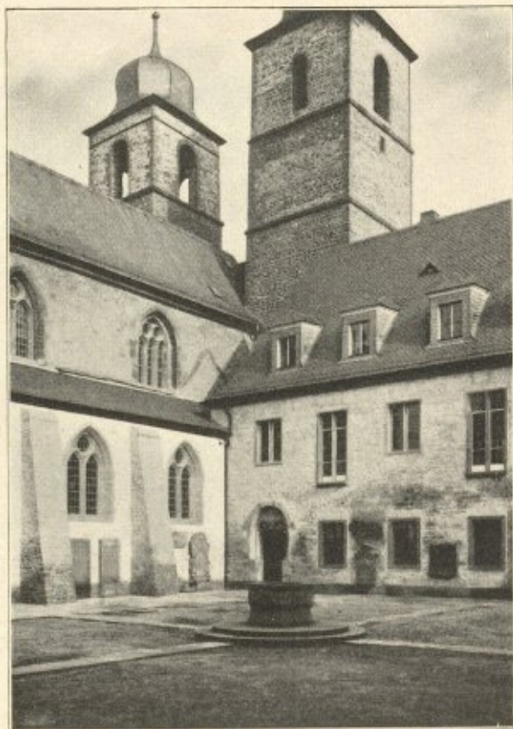
Abb. 28 a: Nordostecke des Kreuzhofes nach der Wiederinstandsetzung
