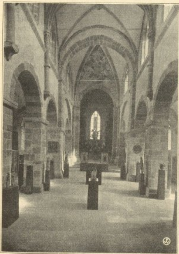
Abb. 2: Innenansicht der Andreaskirche mit Blick nach dem Chore nach Wiedereinfandsetzung
