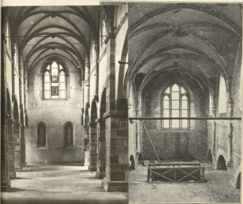
Abb. 21: Gotische Dienste mit den alten Holzgewölben über dem Hauptschiff
