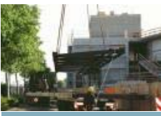
Anlieferung der Stahlträger für die Dachkonstruktion (Saal Neubau)
